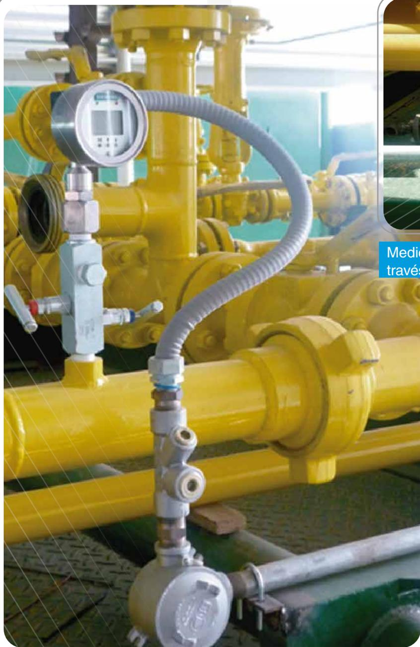
Sensores de Presión y Temperatura digitales
