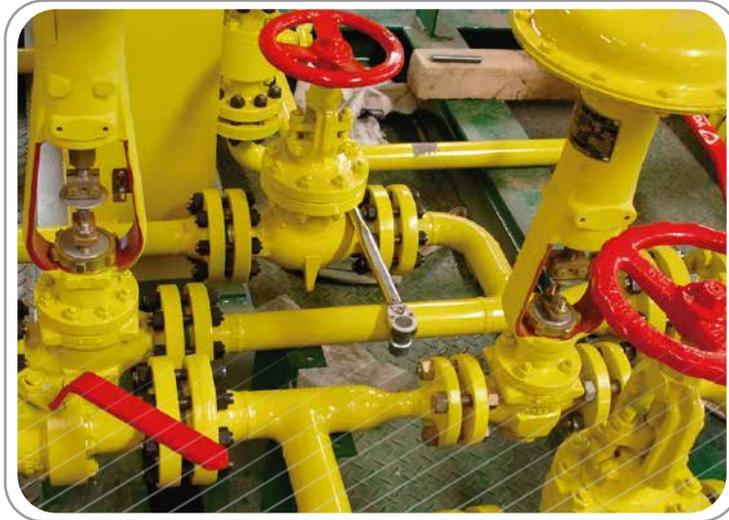
Se encuentra previsto de una entrada que se divide en dos líneas independientes que poseen dos choke fijo, lo que permite cambiar el orificio con el pozo en producción.
